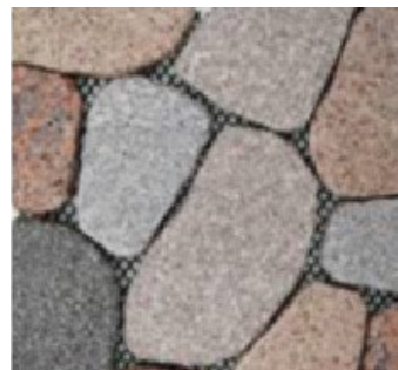
Skårne marksten, der ligger tæt, er et eksempel på belægning, der harmonerer med den gamle markstensbelægning, men er mere gangvenlig
