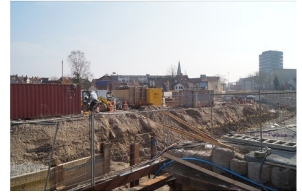
Udgravning i området, april 2015
